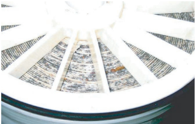
图 6-8 颗粒物污堵的膜元件端面图
