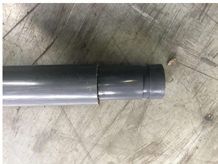
图 6-2 将涂好胶水 DN40 管路，插入到
